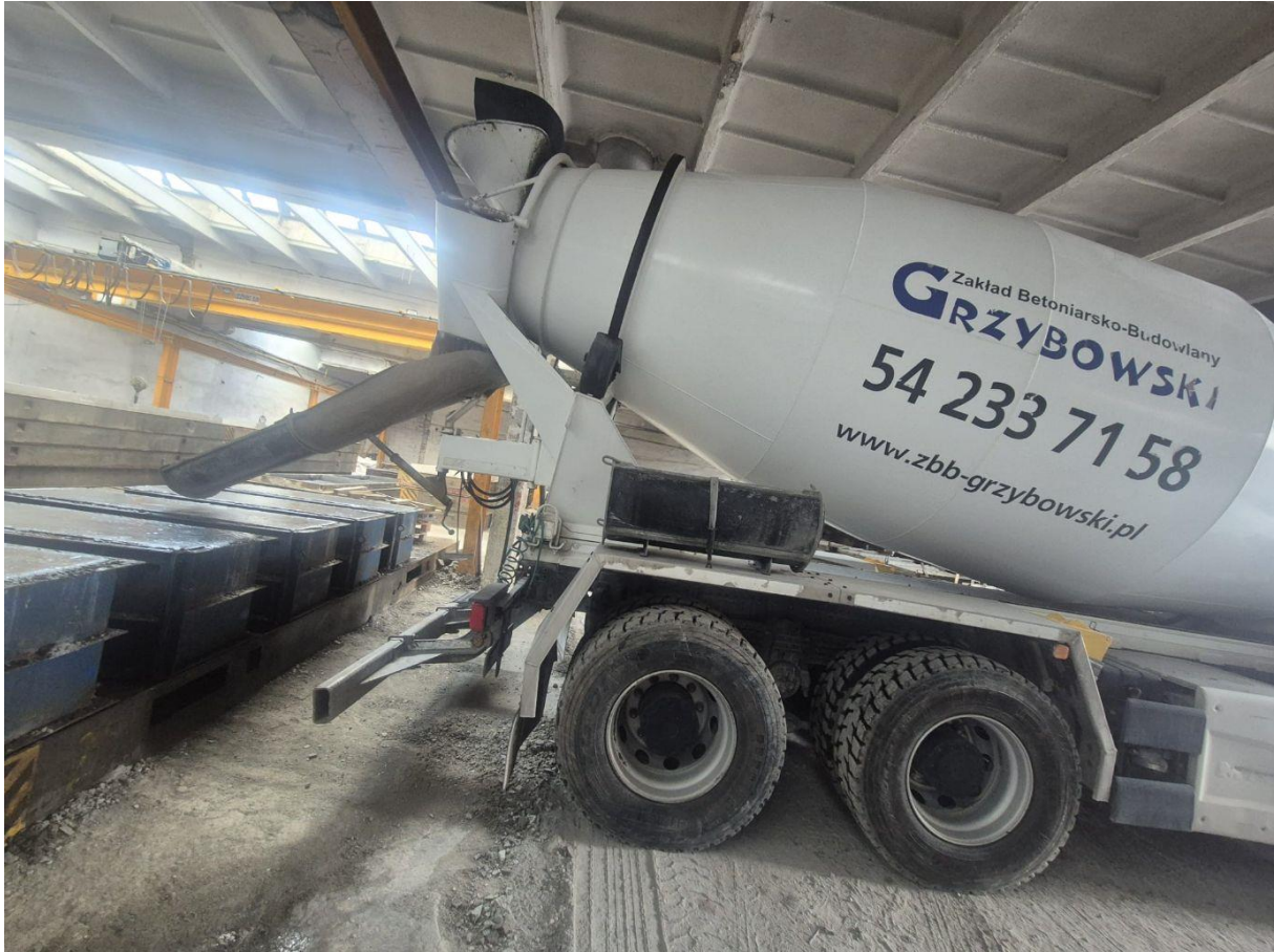
Rysunek 4.1: Zakład Betoniarsko-Budowlany Andrzej Grzybowski – beton towarowy
